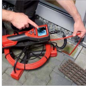
Yağmur drenaj boru kontrol
